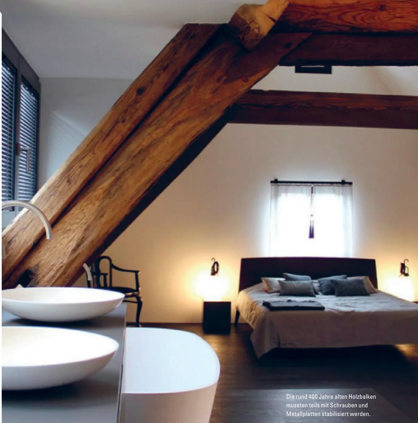
Die rund 400 Jahre alten Holzbalken mussten teils mit Schrauben und Metallplatten stabilisiert werden.
